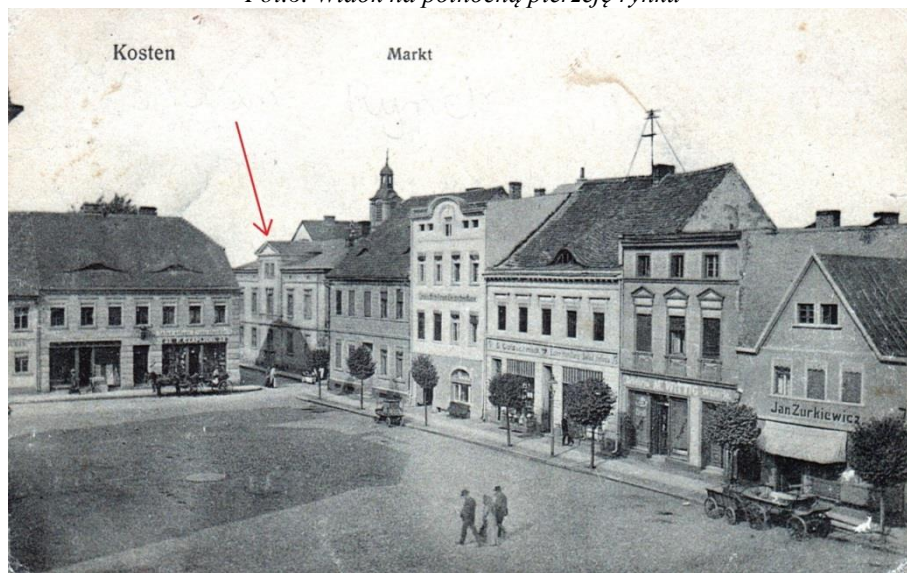
Fot.6. Widok na północną pierzeję rynku
