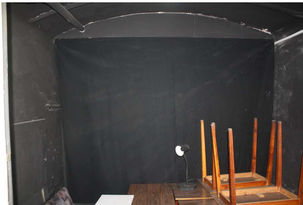
Rysunek 2. Pomieszczenie piwniczne - ściana z oknem.
