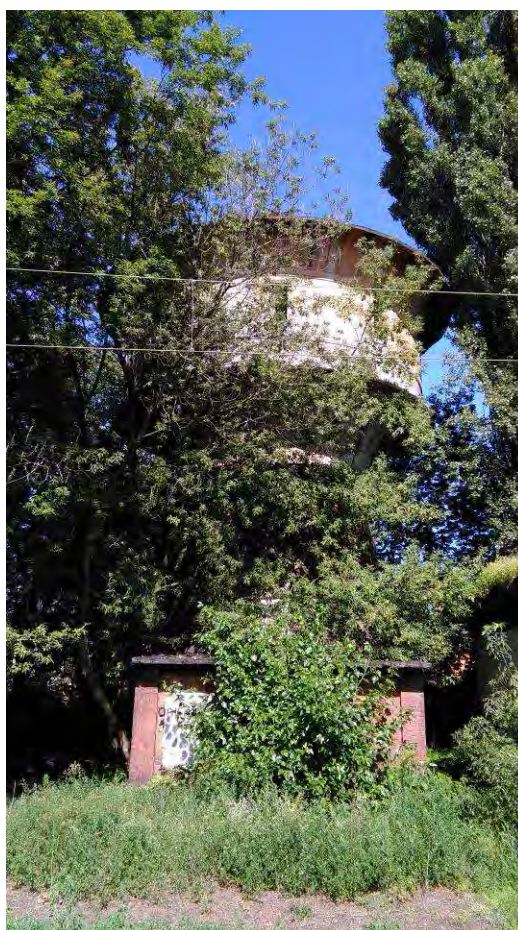
Rycina 28. Zarośnięta krzewami i drzewami kolejowa wieża ciśnienia na terenach pokolejowych
